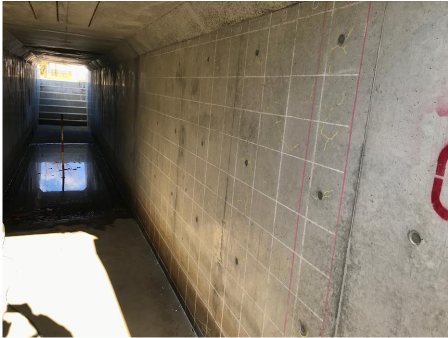
樋門測定箇所
