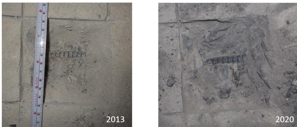
写真-1.1.21 鉄筋調査（底盤はつり）結果
