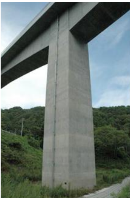
写真-1.1.1 調査対象橋脚 3)
