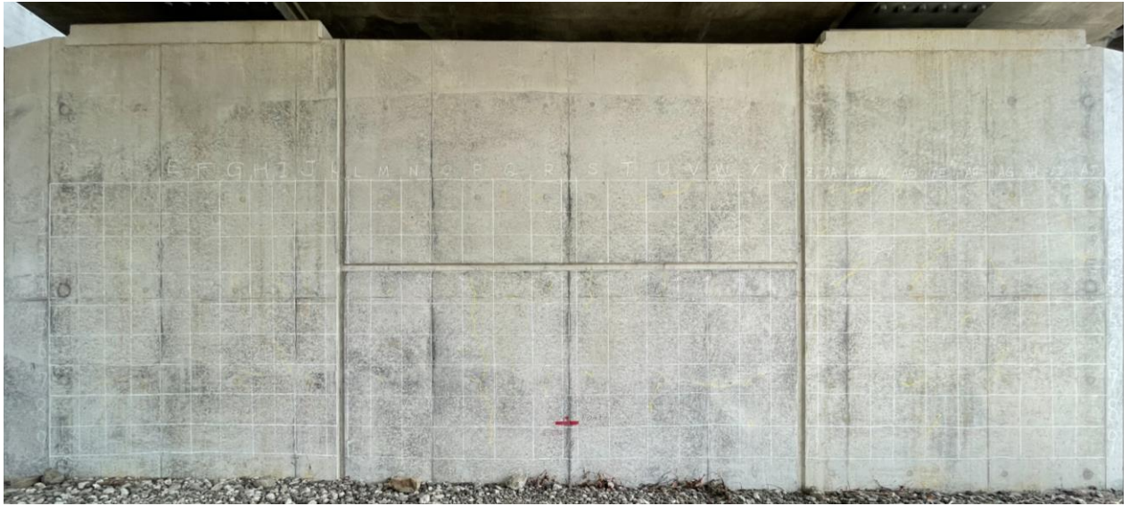
写真-4.1.2 高架橋橋脚部 (2014 年竣工)
