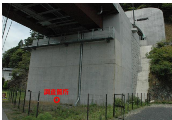
写真-1.1.3 調査対象橋台
