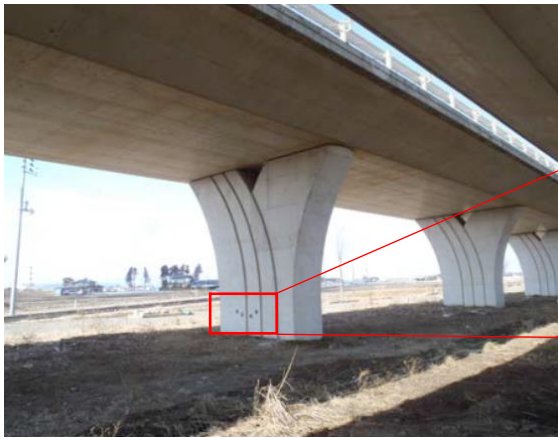
写真-1.1.6 調査対象橋脚 3)
