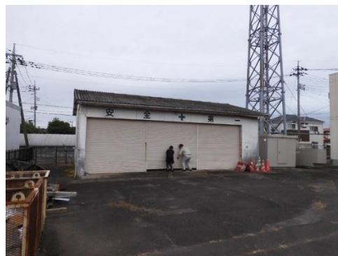
写真-1.1.8 附属建造物（倉庫）の外観
