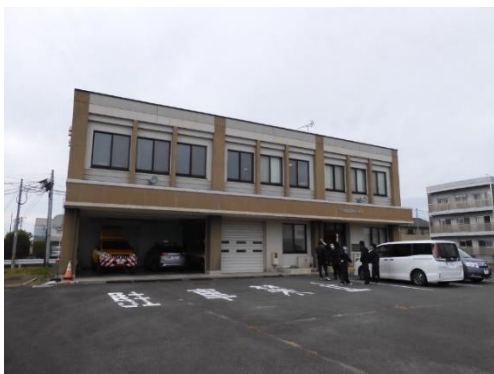
写真-1.1.7 調査対象建物の外観
