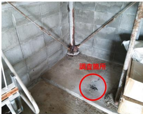
写真-1.1.9 倉庫床の調査箇所
