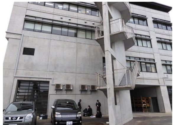
写真-1.1.12 調査対象建物の外観
