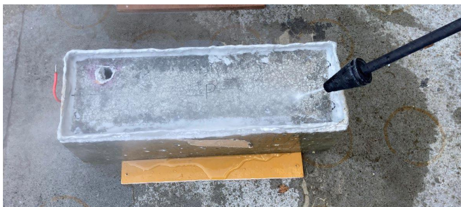
写真-1.2.2 洗浄状況
