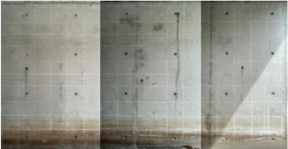
写真-4.1.1 樋門の側壁 (2019年竣工)
