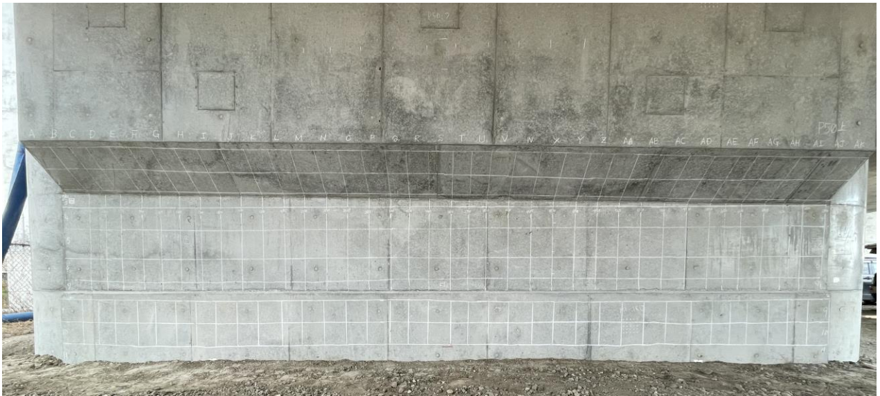
写真-4.1.3 高架橋橋脚補強部 (2021 年竣工)
