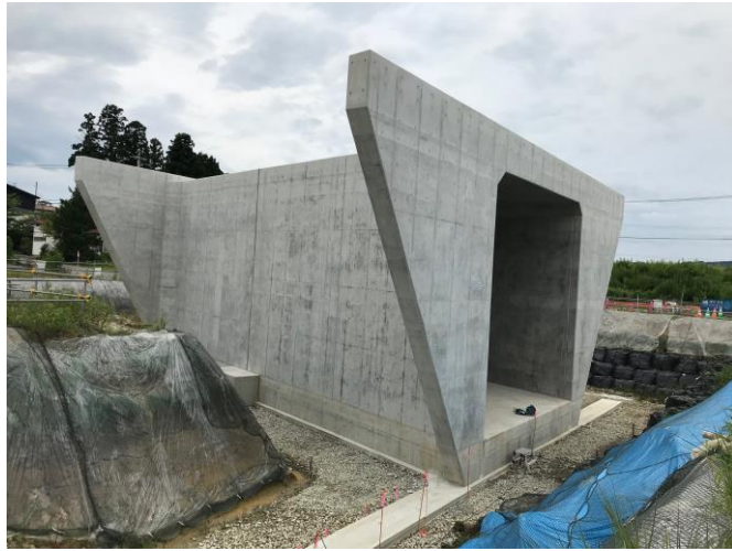
ボックスカルバート全景
